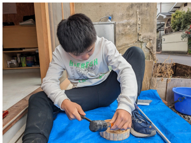
図5 破片をノミで落とす
